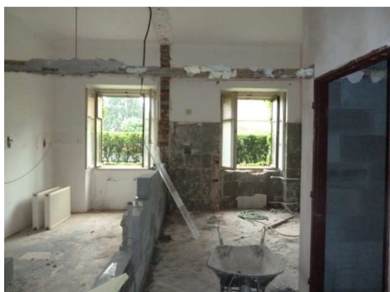
koupelna v době modernizace
