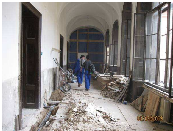
chodba IV. úsek v průběhu oprav
