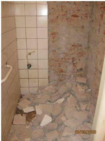
WC rekonstrukce – podkroví
