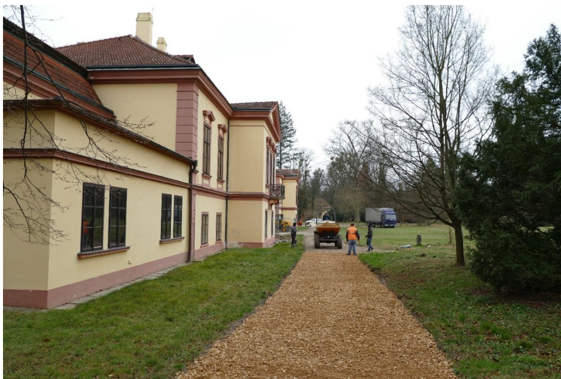
Oprava parkových cest
